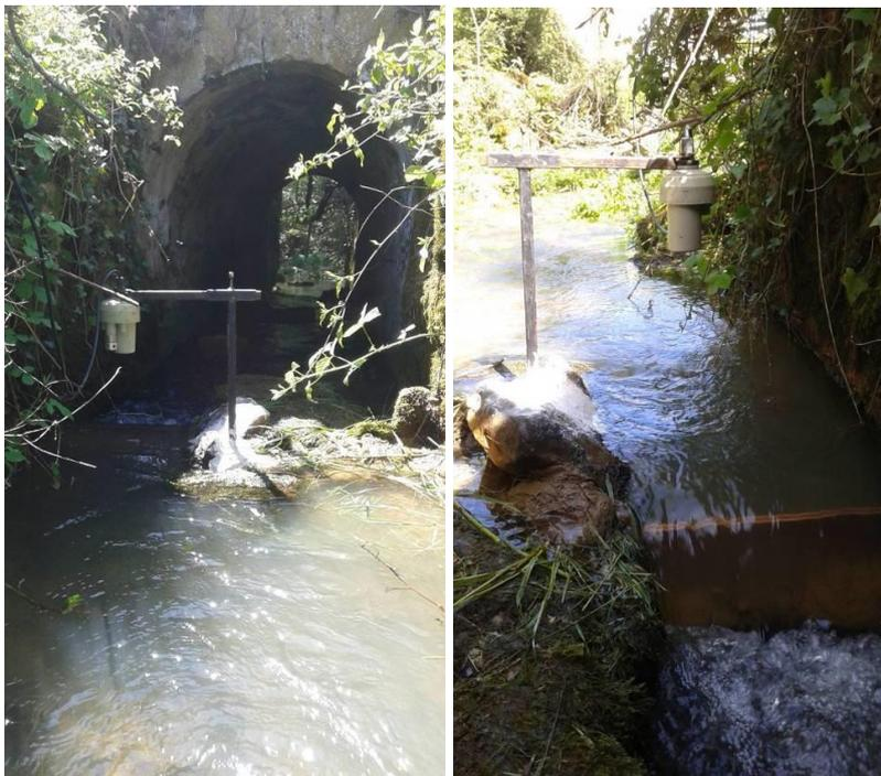
Figure 19 : photographies du montage de mesure de débit -seuil rectangulaire et sonde à ultrason-
